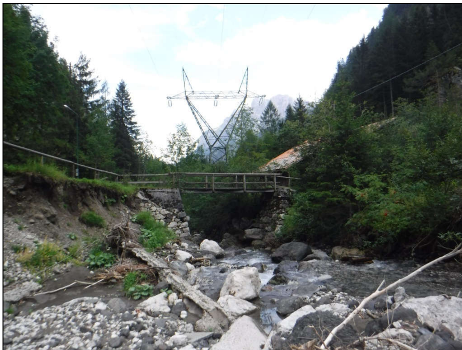
Figura 4.18 - Torrente Pettorina in località Malga Ciapela (ST_7) - foto verso valle, agosto 2019
